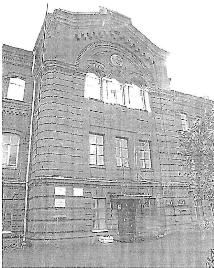
Фото 2. Фрагмент главного (восточного) фасада.
