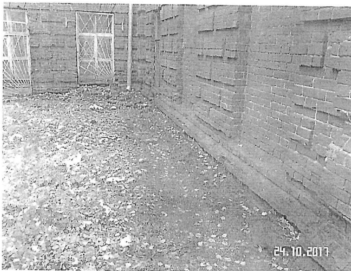
Фото 11, 12. Фрагменты фасада, деструкция кирпичной кладки.
