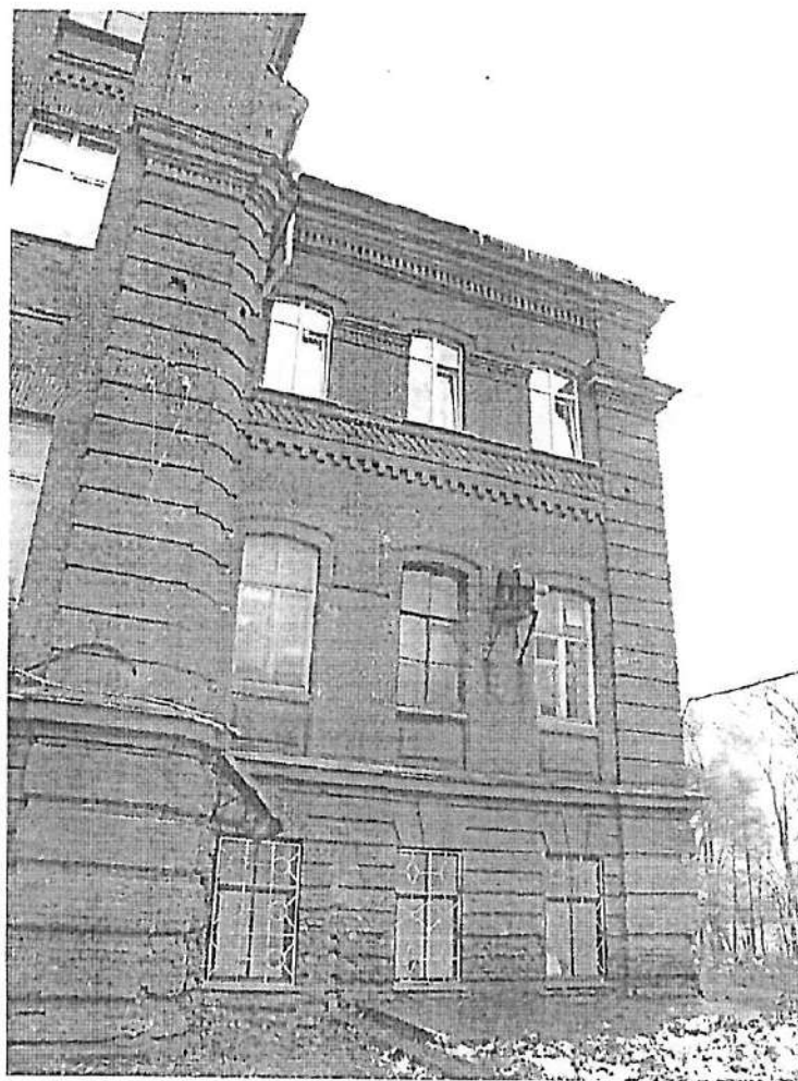
Фото 17. Фрагмент западного фасада.
