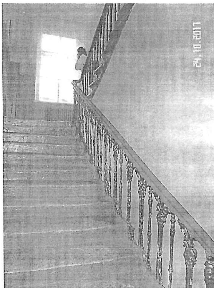
Фото 37, 38. Фрагмент парадной лестницы. Чугунное ограждение.
