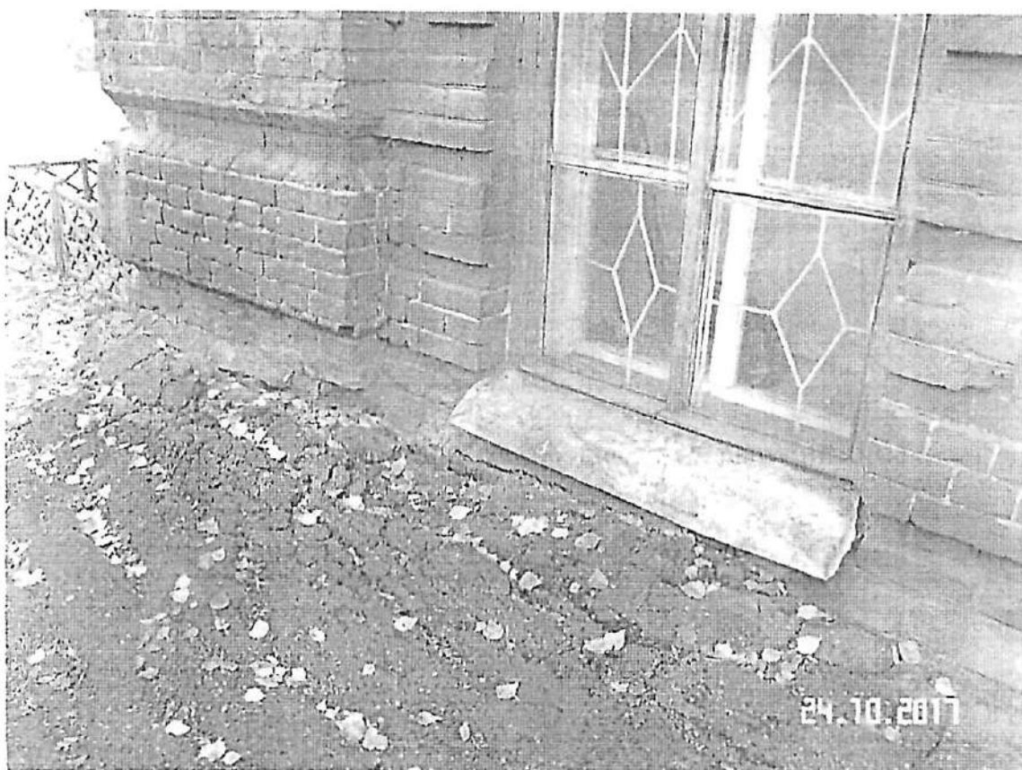
Фото 5, 6. Фрагменты фасада. Поражение плесенью, выпучивание отмостки.
