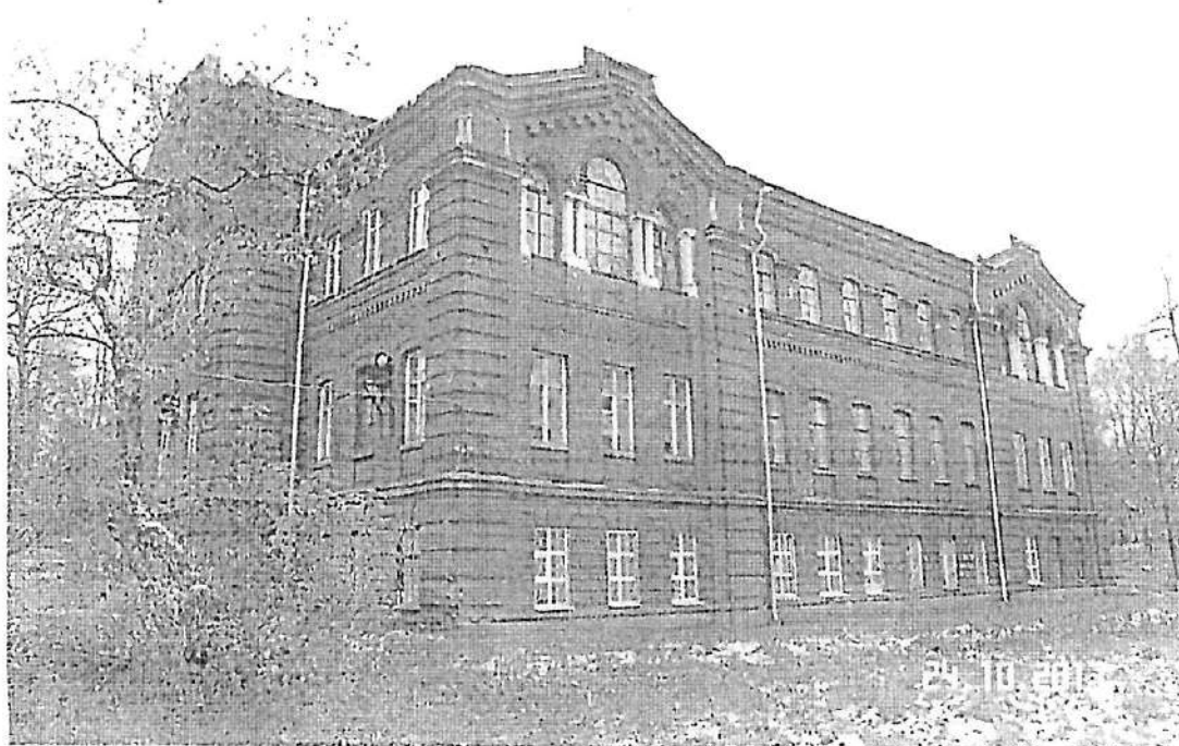
Фото 18. Боковой фасад (со стороны реки).
