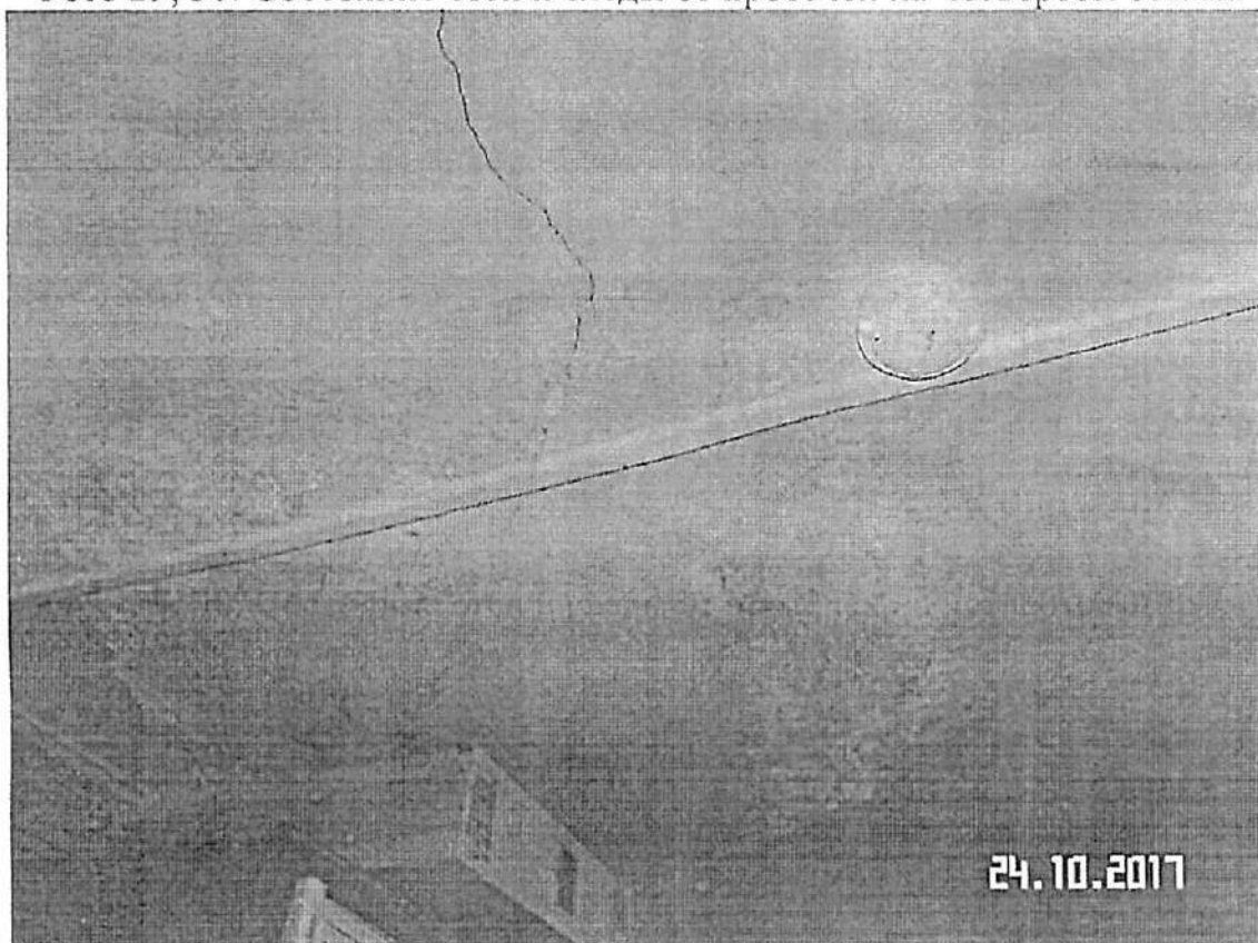
Фото 29, 30. Состояние стен и следы от протечек на четвертом этаже.
